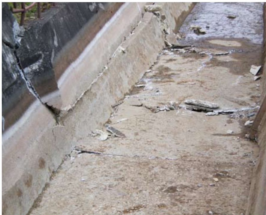
図6 取水路の底面および側面の近接写真。側面が座屈変形する様子が見える。
