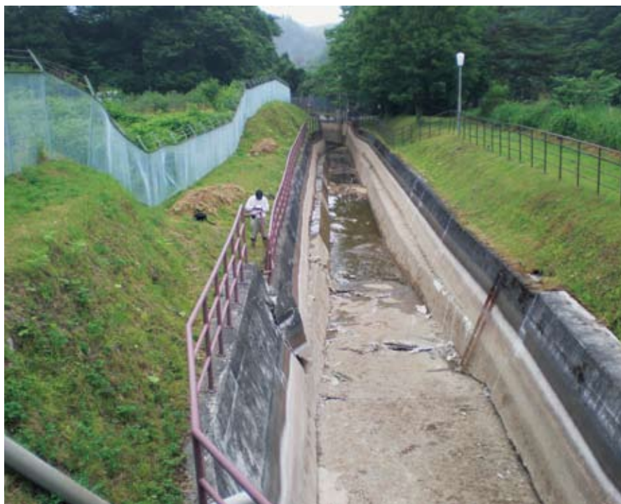
図5 取水路周辺の構造物の短縮変形(地点8)。水路やフェンスが短縮変形を受けていることがわかる。写真奥が下流側。
