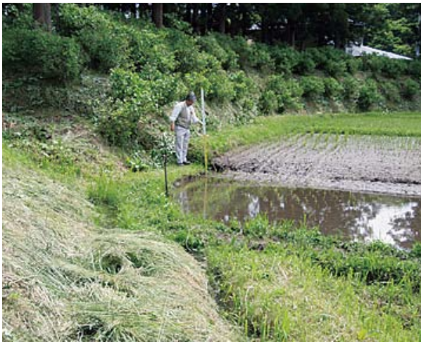
図3 一関市柞木立、水田を変位させる東上りの小崖地形北端の写真。人物足元の畦道や右側の水田土壌が明瞭に食い違っていることがわかる。さらに右側(南東側)では緩い撓曲変形をとまう。
