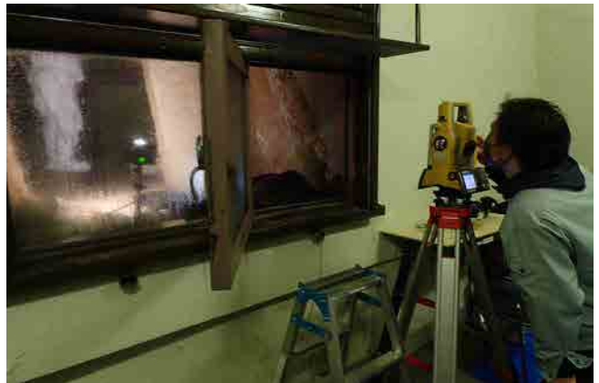
4. トータルステーションを用いた横穴内の標定点の測量作業状況
