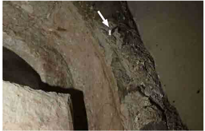
2. 温湿度計の設置状況（矢印・羨門右外側のモルタル部分）
