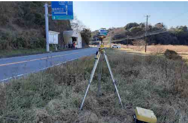
3. 基準点 R3K1 での GNSS 測量作業状況
