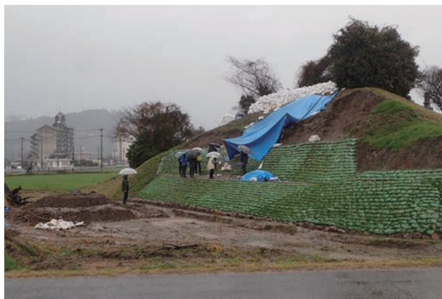
図6 雨中の作業状況（2月19日）
