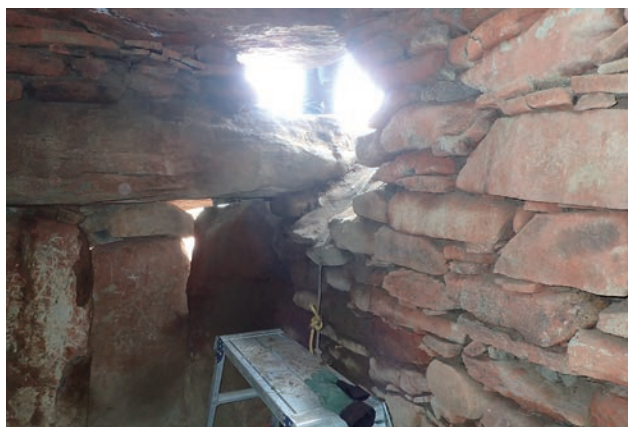
図5 石室内から見た盗掘孔
